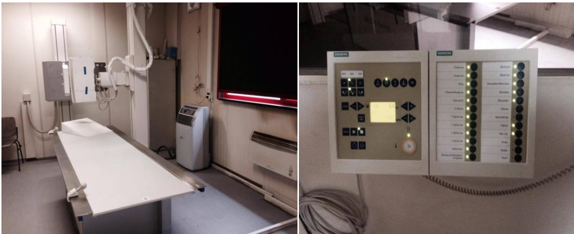
Fig.19: Reparti i radiografisë në QKMF në Rahovec. Dhoma e ekspozimit të pacientëve me rreze X (majtas) dhe paneli i kontrollit (djathtas)
